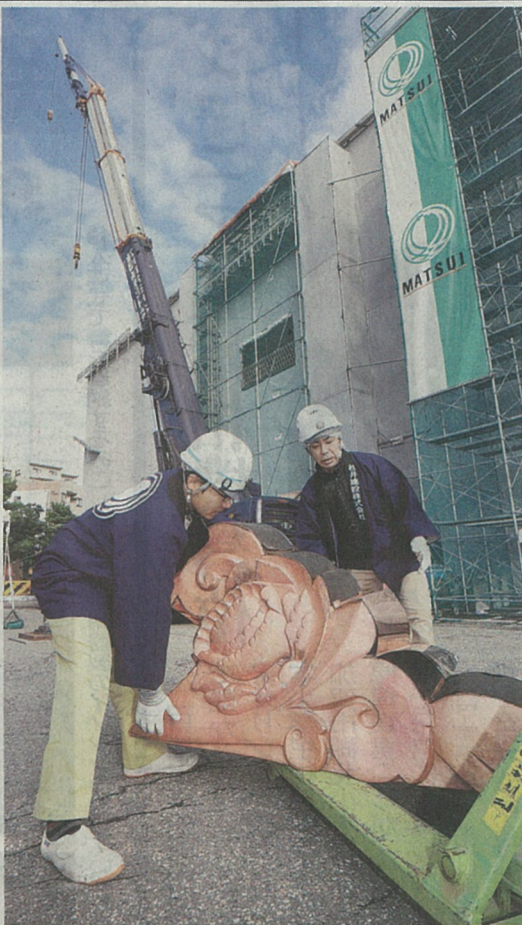
屋根の上につり上げるために、クレーンに取り付けられる鬼瓦の一部。金沢市安江町の金沢別院で
